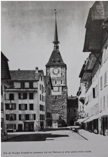
Zustand vor der Restaurierung
