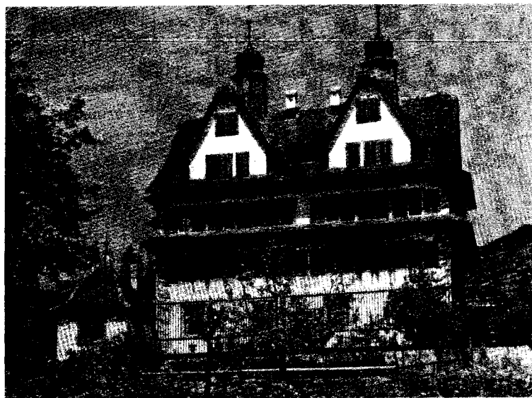
180. Schwyz. Ital-Reding-Haus. Originell ausgebautes Herrenhaus von 1609, um 1663 mit Satteldach, zweigeschossigen Kreuzgiebeln und Kuppeltürmchen versehen
