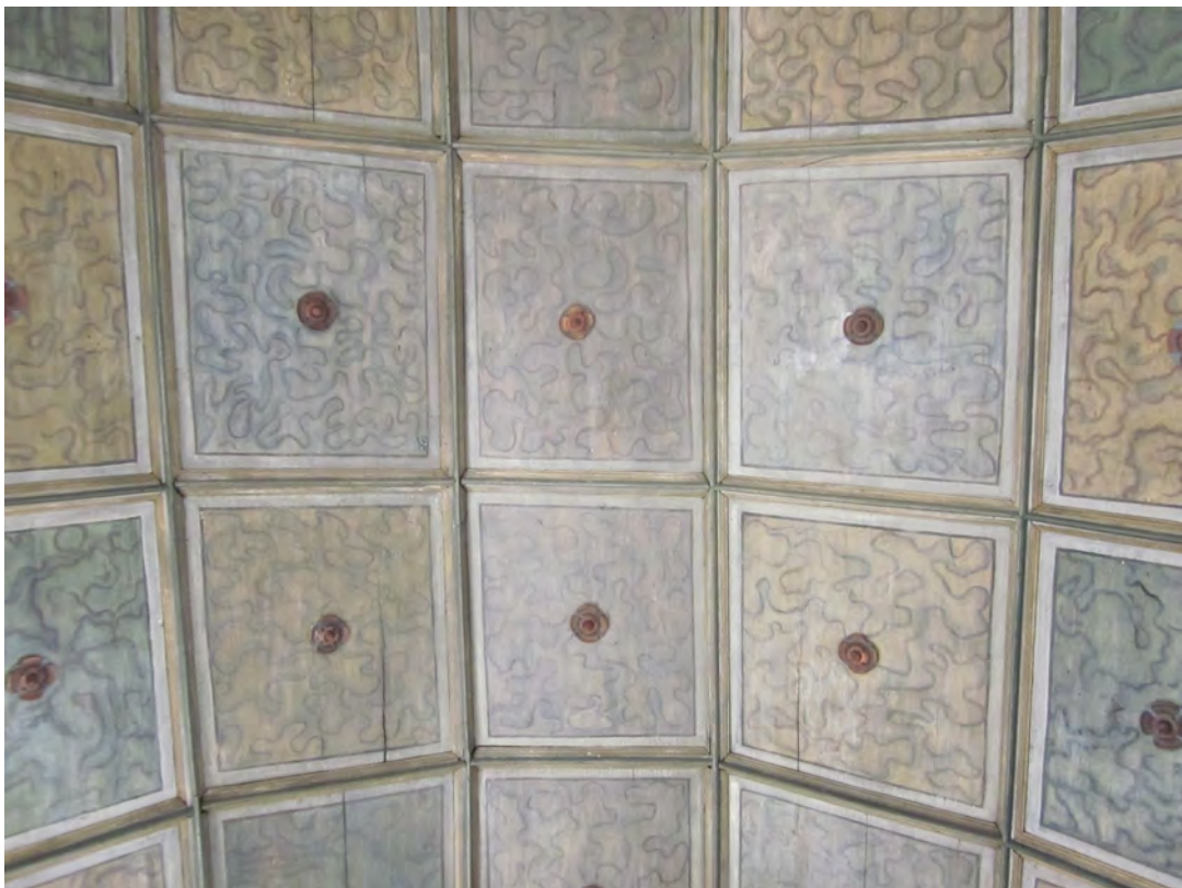
Blick zur bemalten Holzdecke des Beinhauses
